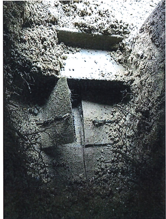
Foto 20: Fibertex og membran under/ved stålprofil.
