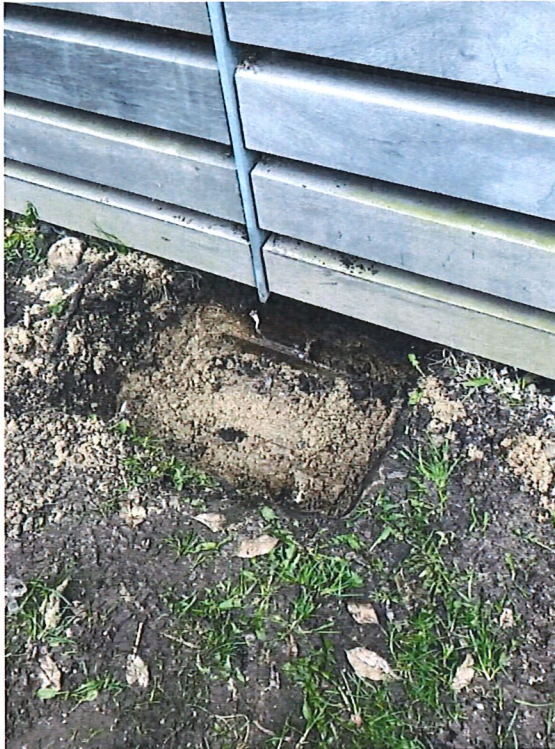
Foto 19: Opgravning ved skur.
