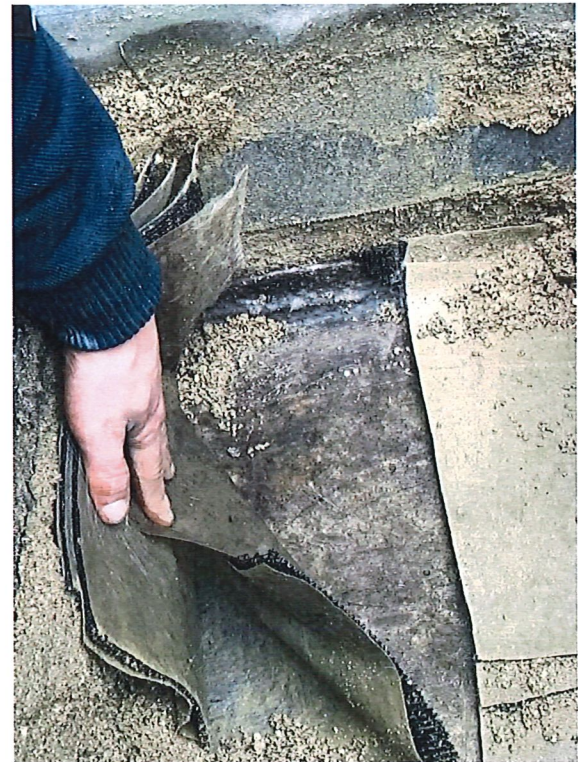
Foto 18: Opgravning ved facade. Inddækning.
