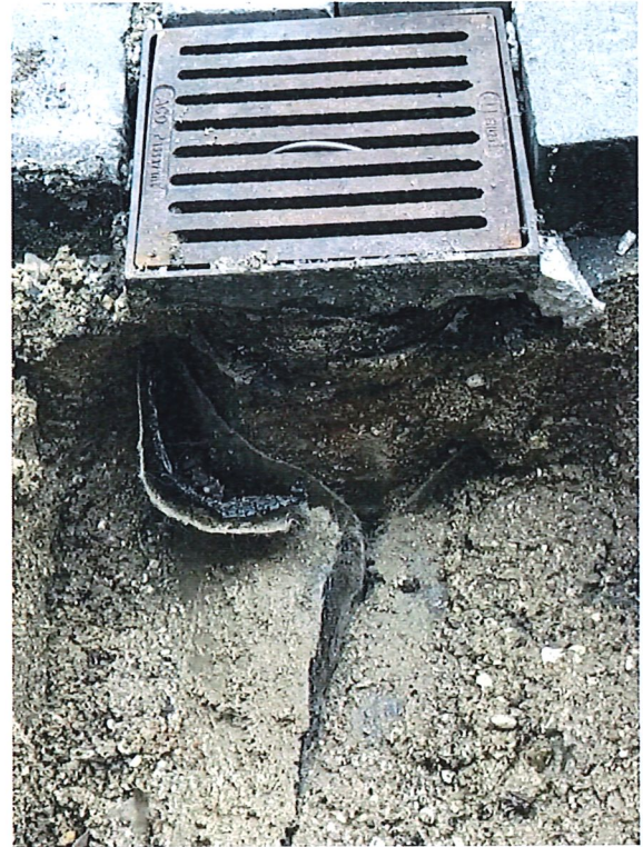
Foto 16: Inddækning af fibertex omkring afløb.
