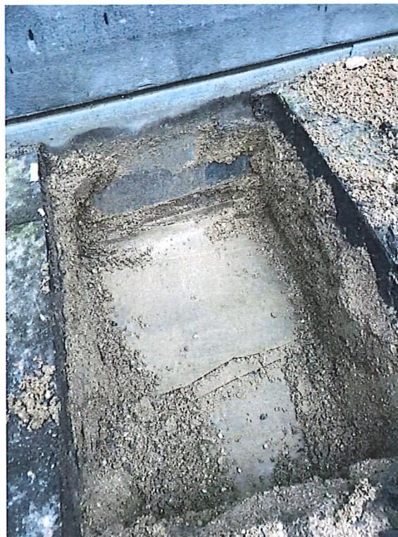
Foto 17: Opgravning ved Facade.
