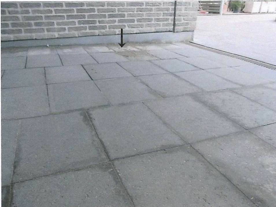
Foto 3 – Fugt langs sandfyldte fuger. Pil angiver optagen flise.
